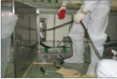
그림 5. 핫셀내부와 작업구역간의 배선작업.
