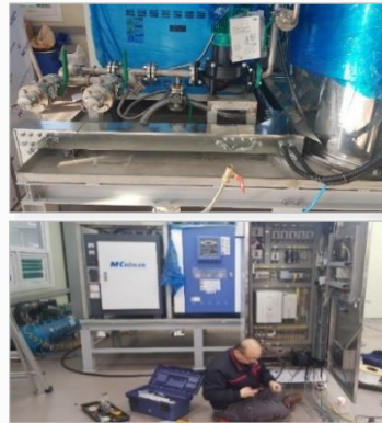
○ 배관 및 전기판넬 작업
